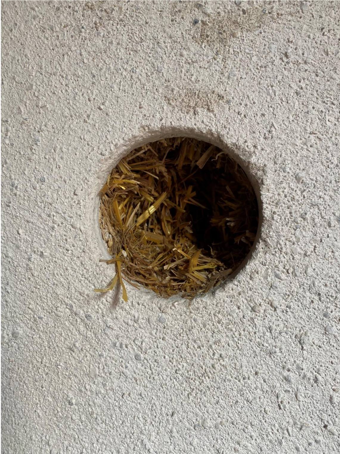
Carottage diamètre 9cm dans l'enduit côté intérieur proche des sondes hygrométriques.
