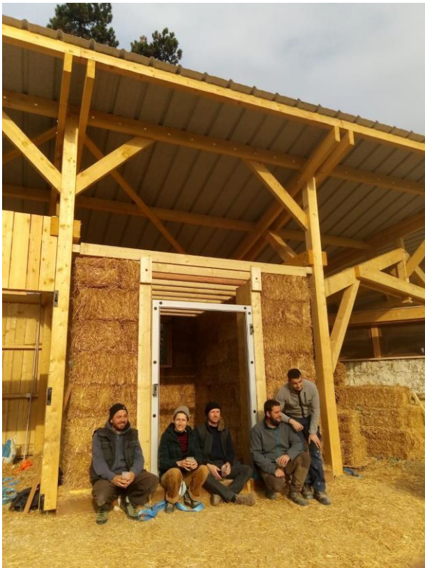
Phase chantier lors de la pose des bottes de paille.
