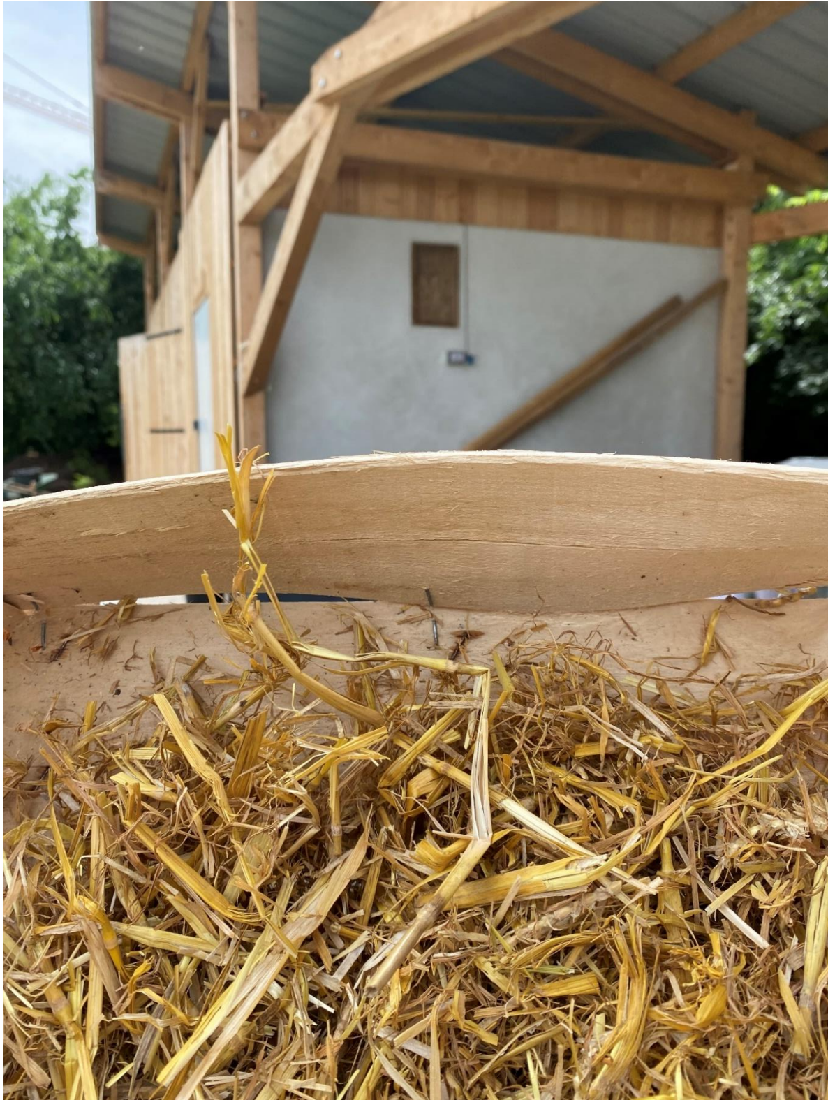
Etat de la paille extraite du mur lors du carottage vu à la lumière du jour.
