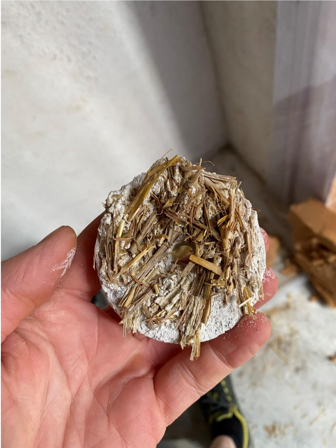
État du carottage côté paille.
